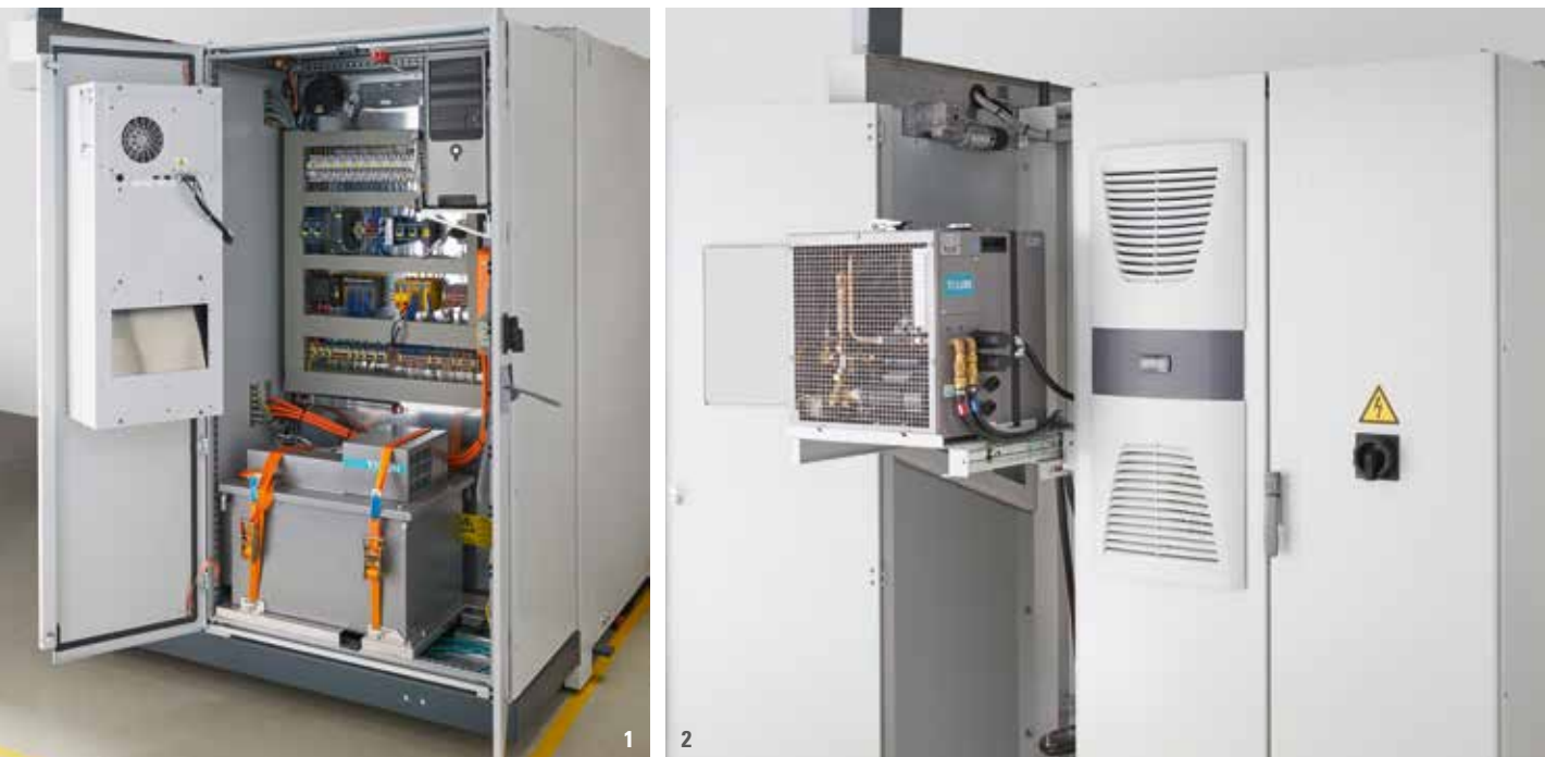
1 Wichtige Komponenten sind sicher verstaut, um sie vor rauer Umgebung und Schäden zu schützen und damit die Verfügbarkeit des Systems zu erhöhen. 2 Einfache Wartung mit dem herausfahrbaren Kühler
